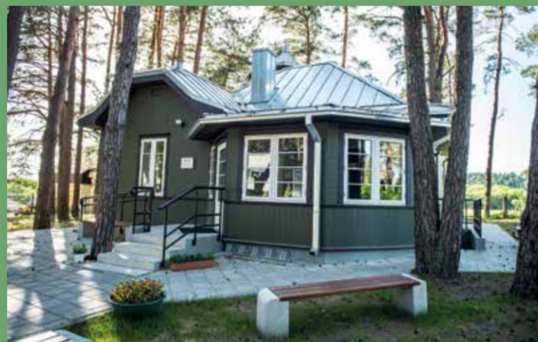
1 INŽINIERIAUS V. REKLAIČIO VILA VILLA OF ENGINEER V. REKLAITIS
